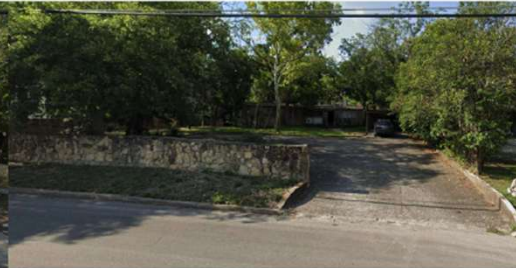
530 CORONA AVENUE (SUBJECT PROPERTY)
