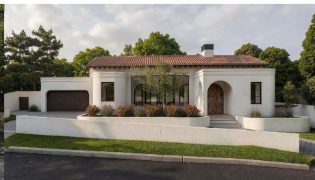
530 CORONA AVENUE (SUBJECT PROPERTY)
